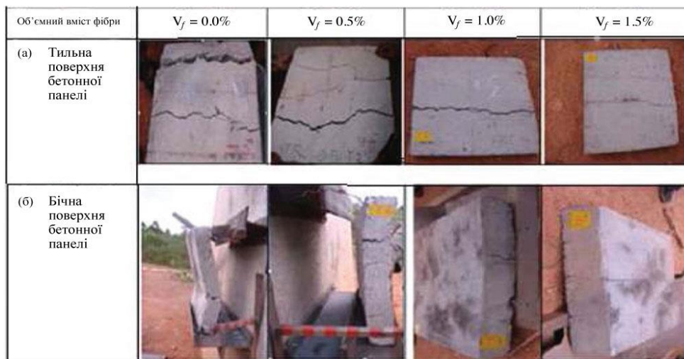
Рис. 5. Вплив відсотка фібрового армування на характер пошкоджень СФБ-плит [23]
